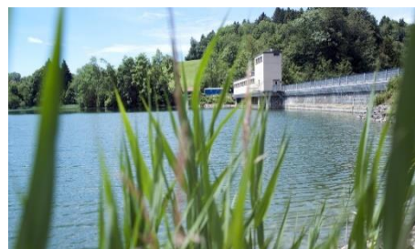
Bahnstromproduktion vom Kraftwerk «Etzelwerk»: 250 GWh/a
