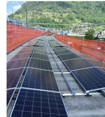
Entwicklungsprojekt für ein semitransparentes, bifaciales Standard-PV-Perrondach (links) und PV-Aufdachanlage auf dem Perrondach in Sargans (rechts). Bilder: SBB.
