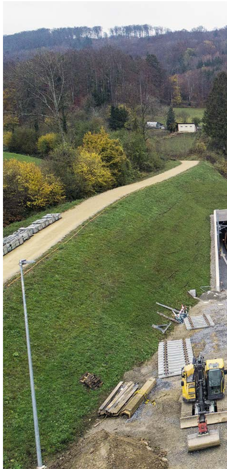
Corridoio di 4 metri: galleria del Bözberg portale
