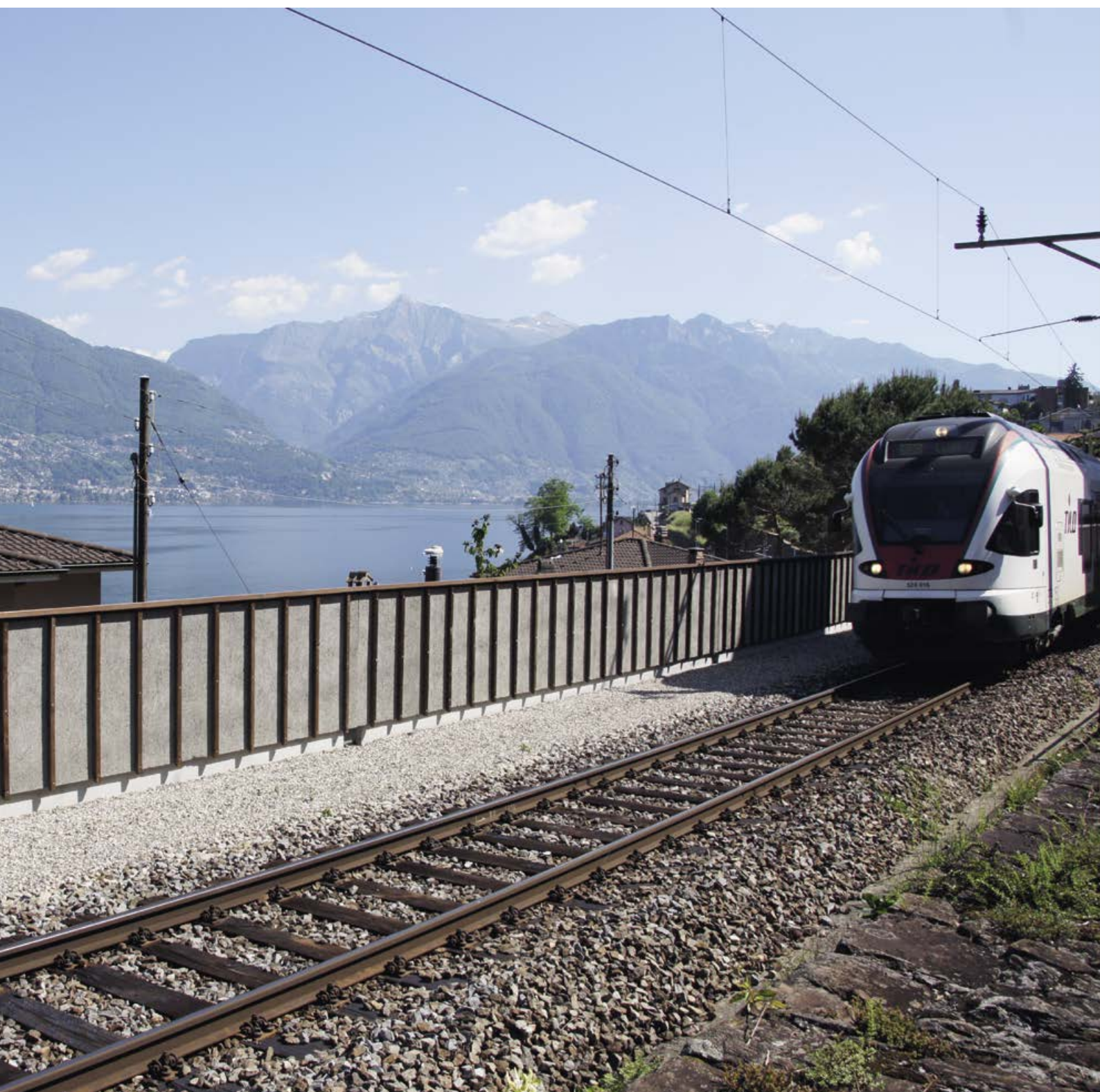
Risanamento fonico delle ferrovie: parete antirumore a Gerra
