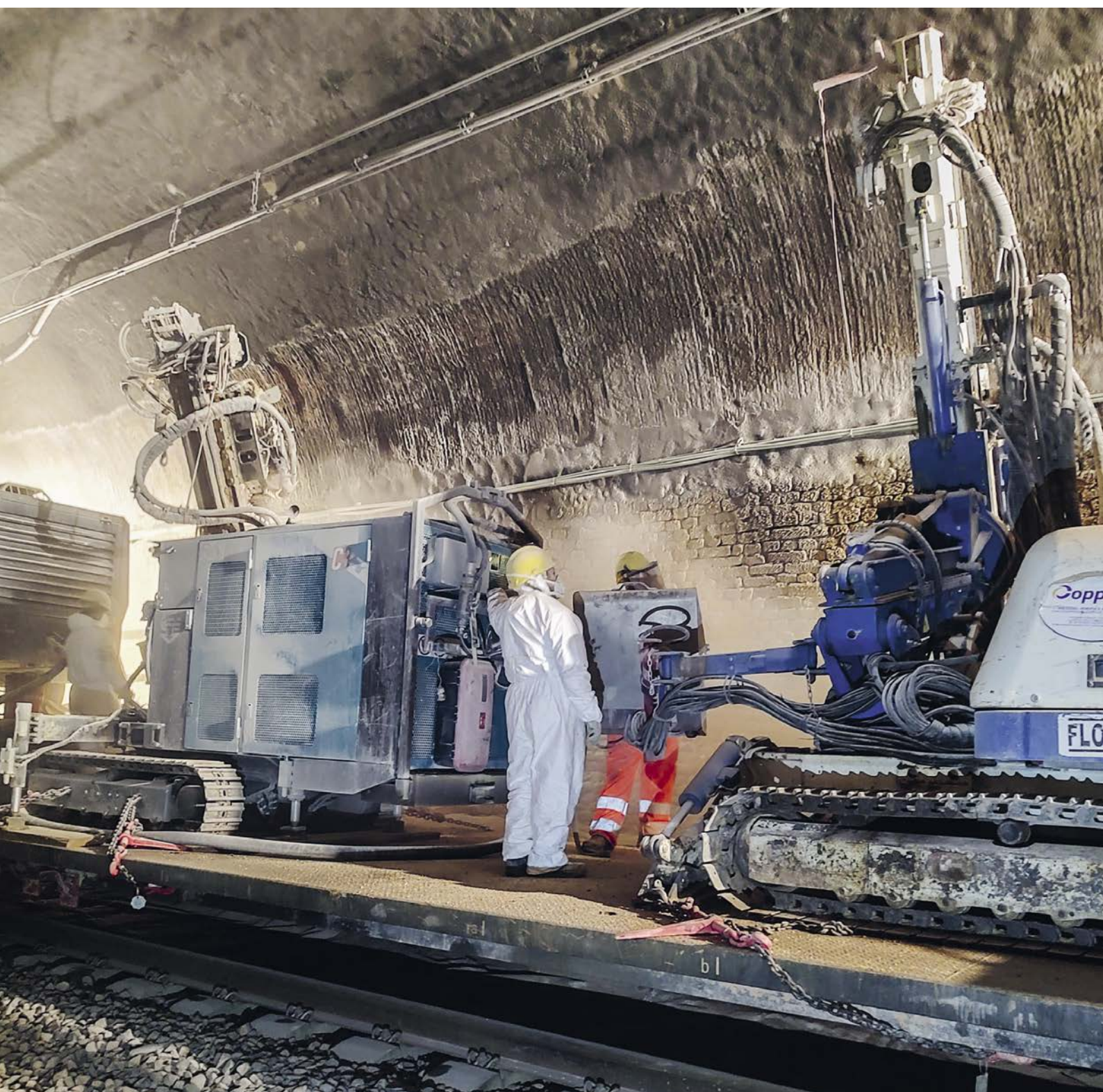
C4m: Linea del Sempione, ampliamento del profilo della galleria di Arona
