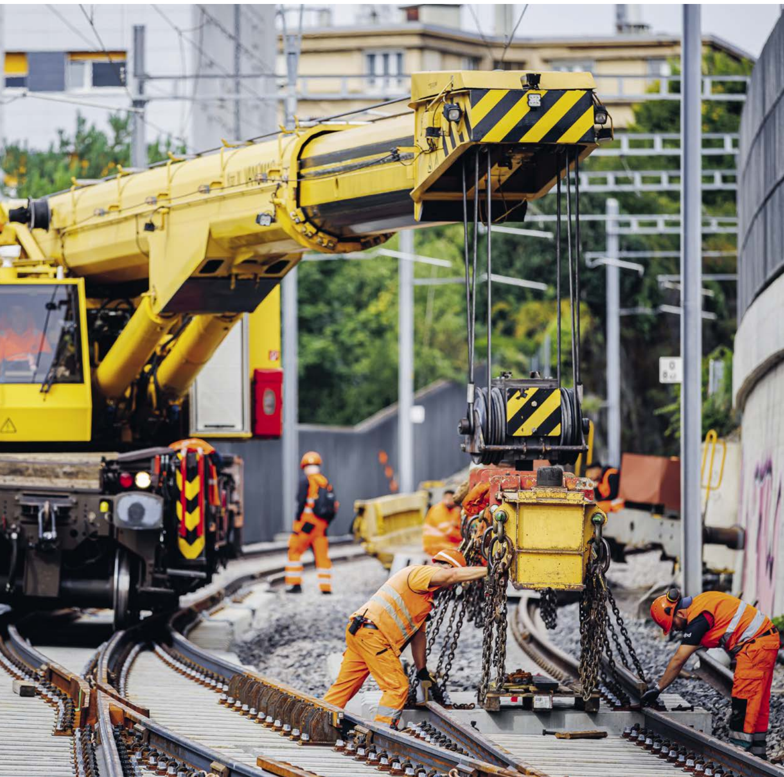
SIF: Ampliamento della stazione di Losanna, installazione di un raccordo di smistamento
