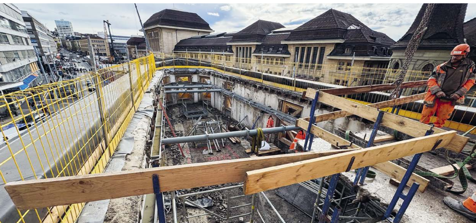
SIF: Ampliamento della stazione di Losanna, lavori di demolizione della copertura alla Pointe de Ruchonnet
