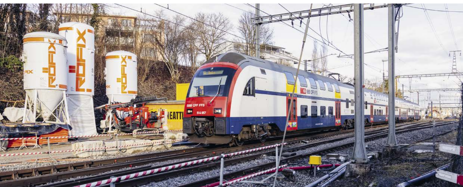
FA35: Zurigo Seebach, ampliamento degli impianti
