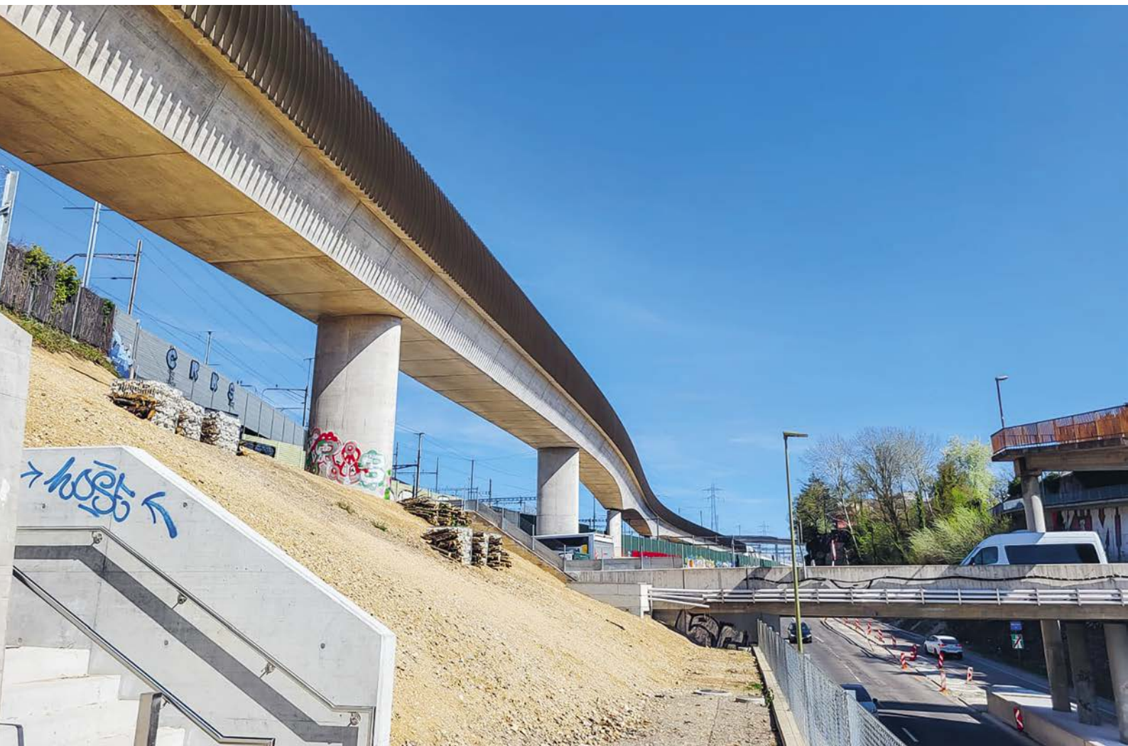
FA25: Basilea Est–Muttentz, opera per separazione dei flussi di traffico
