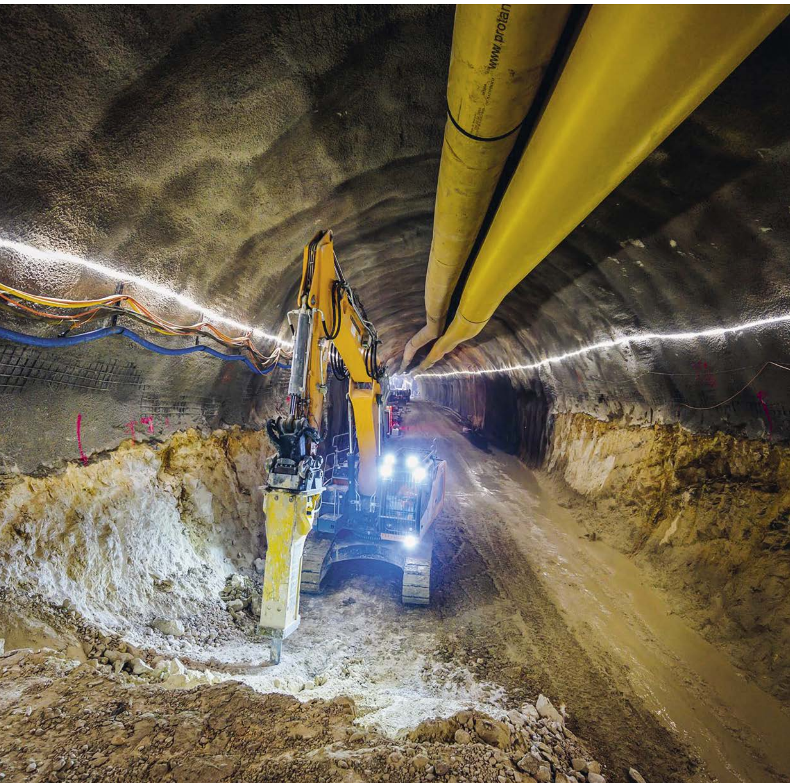
FA25: Ligerz–Twann, raddoppio del binario (lavori nella nuova galleria)
