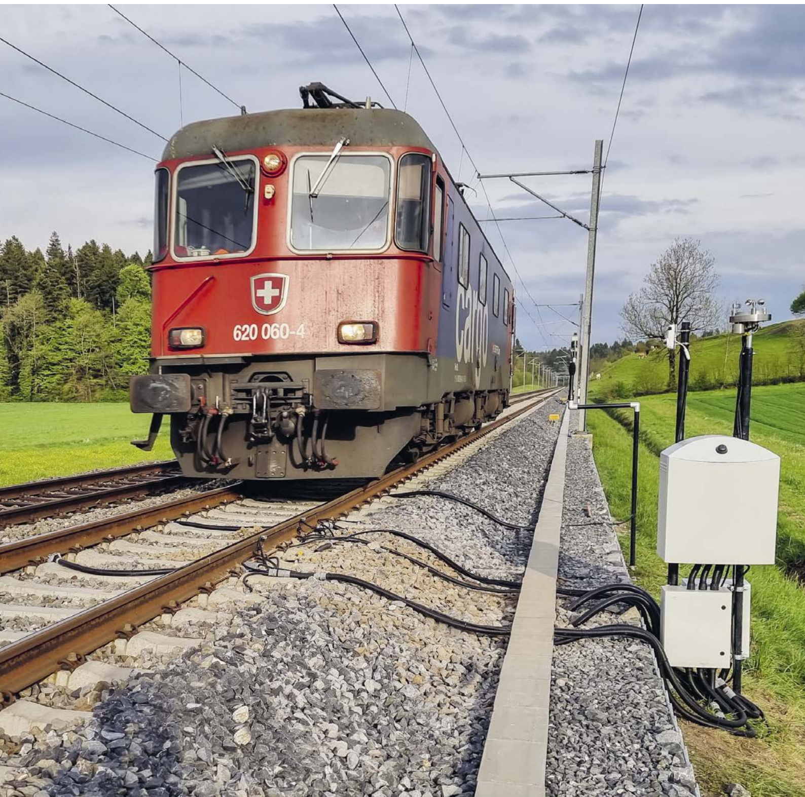
Risanamento fonico delle ferrovie: Tratto di prova sulla linea Sempach–Rothenburg
